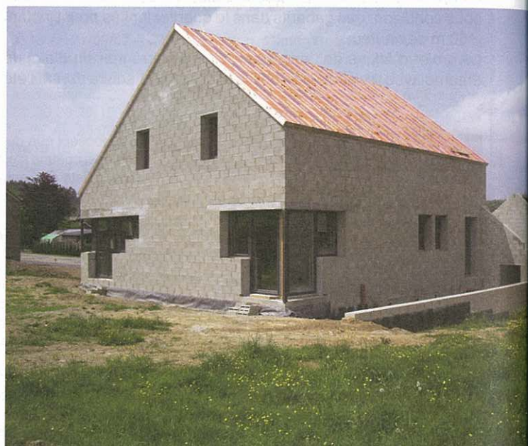
Pièces de vie en façade sud.
